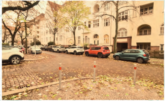
Heinrich-Seidel-Straße-Liliencronstraße: Hier wird eine Querungshilfe benötigt
