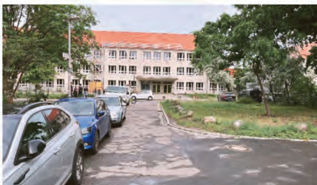
Kreuzung Marksburgstraße mit vier weiteren dort mündenden Straßen
