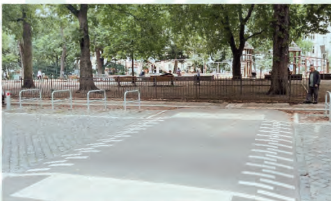
Aufgeplasterte Querungshilfe vor der Grundschule
