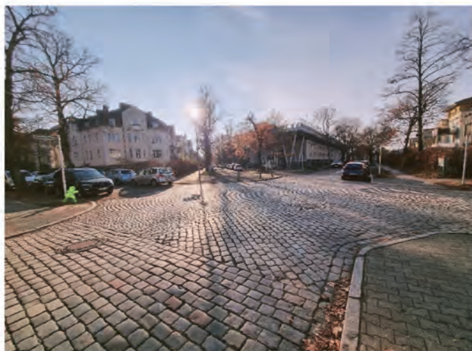
Athene Grundschule, Einmündung Jägerndorfer Zeile mit Sperrfläche und Leitbaken
