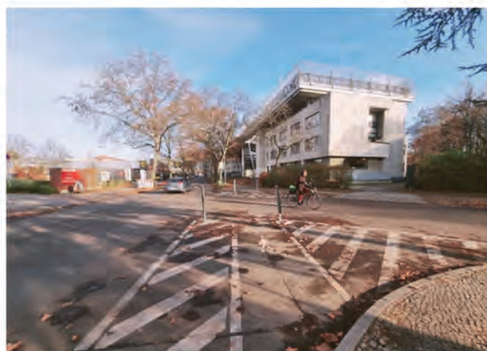
Drakestraße an der Einmündung Curtiusstraße, Blick Richtung Südosten
